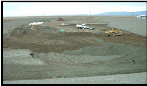
CERCLA Disposal Cell
